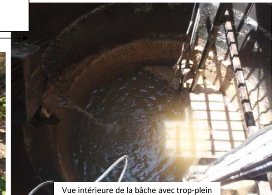
Vue intérieure de la bache avec trop-plein
