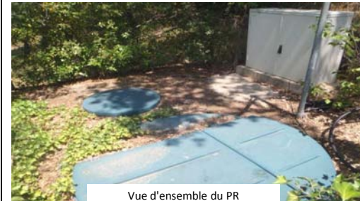
Vue d'ensemble du PR
